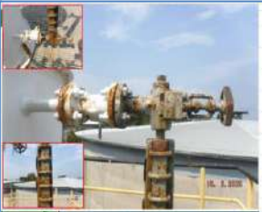
Pic. No. 7 Location : ExpansionTank no. 01GHC10BB001 Description : พบบริเวณรอยร้าว และเกิด Corrosion ที่ Valves, Flange, Bolt&Nut, Sight glass
