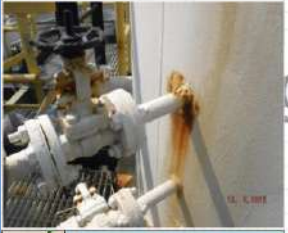
Pic. No. 9 Location : ExpansionTank no. 01GHC10BB001 Description : พบบริเวณรอยร้าว และเกิด Corrosion ที่ Valves, Flange, Bolt&Nut, Sight glass
