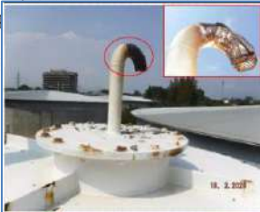
Pic. No. 3 Location : ExpansionTank no. 01GHC10BB001 Description : พบบริเวณรอยร้าว และเกิด Severe corrosion ที่ Shell Plate, Vent with gooseneck
