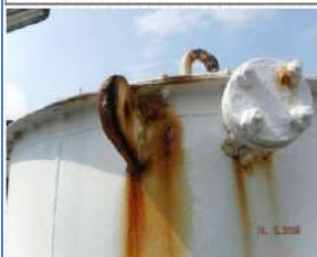
Pic. No. 5 Location : ExpansionTank no. 01GHC10BB001 Description : พบบริเวณรอยร้าว และเกิด Severe corrosion ที่ Shell Plate, Lifting Lug, Bolt & Nut Cover Plate
