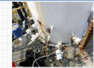
Pic. No. 8 Location : ExpansionTank no. 01GHC10BB001 Description : พบบริเวณรอยร้าว และเกิด Corrosion ที่ Valves, Flange, Bolt&Nut, Sight glass
