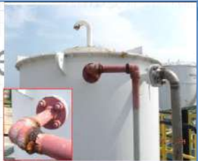
Pic. No. 4 Location : ExpansionTank no. 01GHC10BB001 Description : พบบริเวณรอยร้าว และเกิด Severe corrosion ที่ Shell Plate, Pipeline connection
